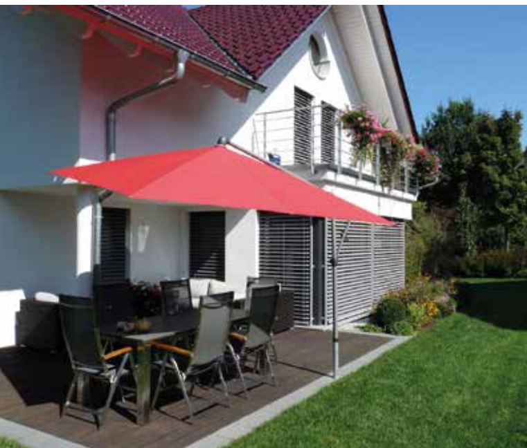
Raffstore schützen vor Blendungen und einem übermäßigen Anstieg der Raumtemperatur, ohne das Tageslicht dabei komplett auszusperrten.
