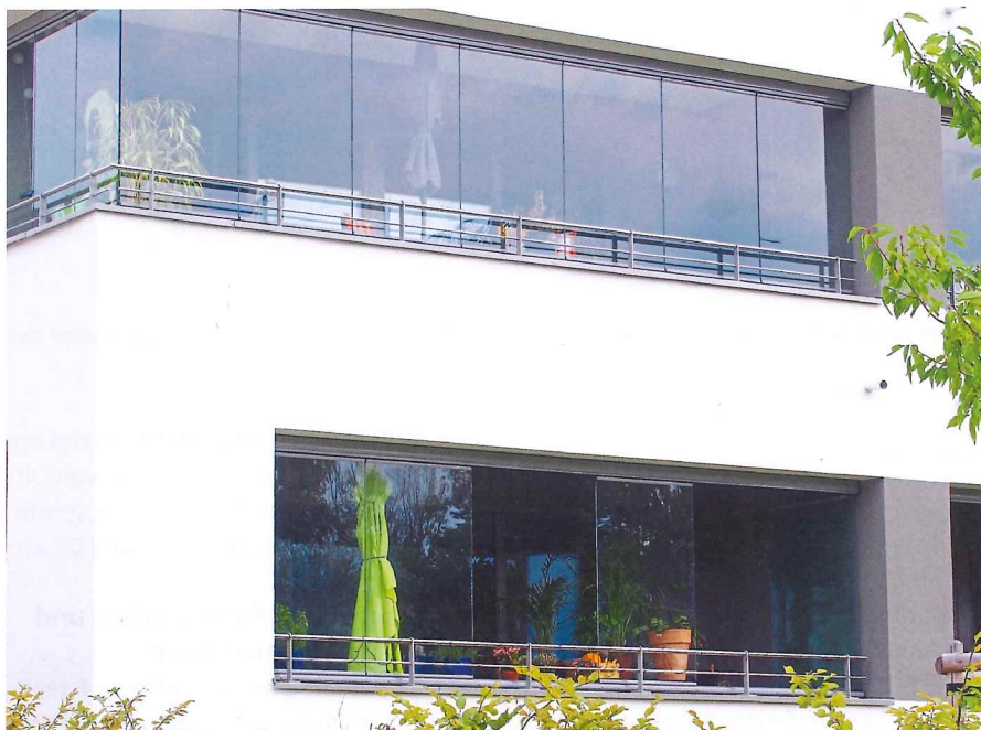
Die Dreh-/Schiebeverglasungen von Lumon eignen sich für Balkone mit mehreren Seiten oder mit geradlinigem Lauf.
