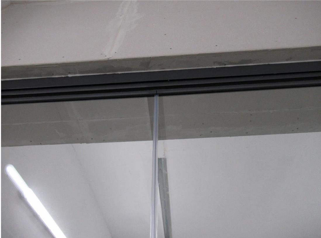
Photo 8: vue de salle de réception, joints EPDM avec interstices de ventilation tous les 250 mm, alternance (Mesurage 5)
