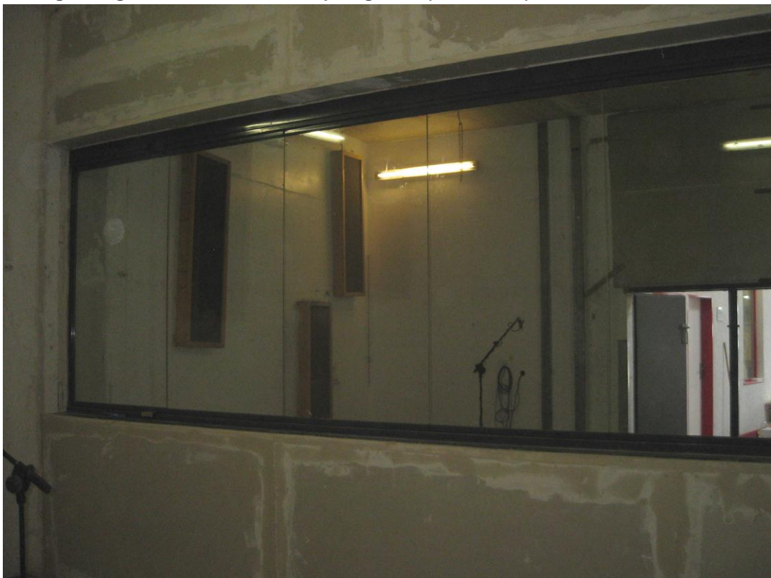
Bild 6: Balkonverglasung Lumon 5, Ansicht Empfangraum (Innenseite)
