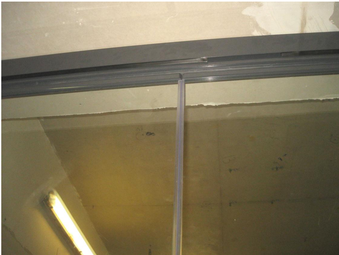
Bild 3: Balkonverglasung Lumon 5 mit Lumon Glas-Brüstung, Detail vertikale PVC-Dichtung
