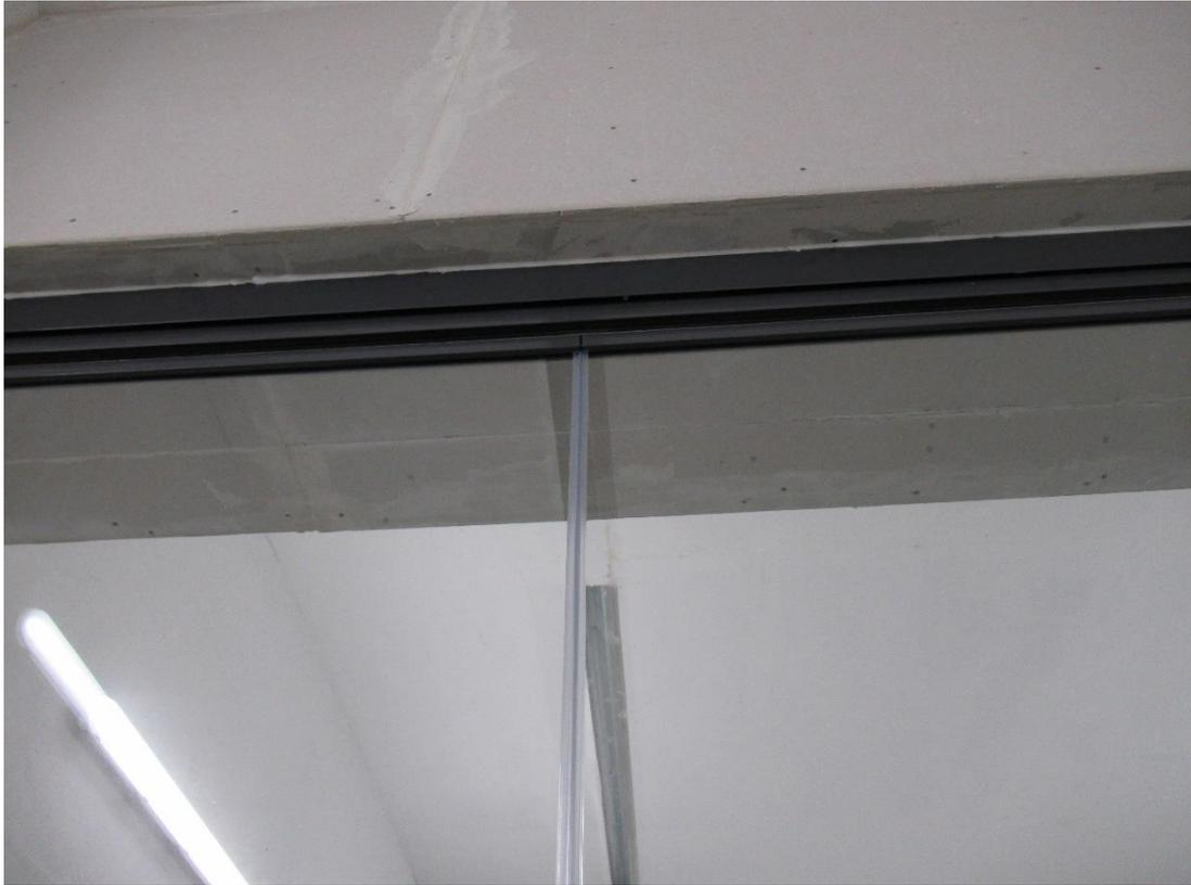
**Bild 8: Ansicht Empfangsraum, EPDM-Dichtung, abwechselnd je 250 mm (Messung 5)**
